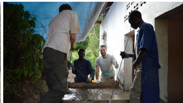
Betonieren des Druckblockes
