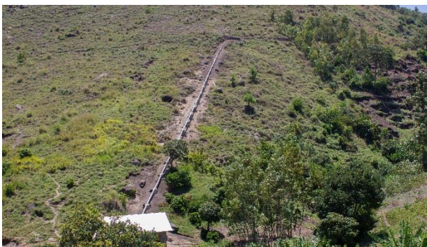
Blick auf das gelagerte Fallrohr und das Maschinenhaus 2
