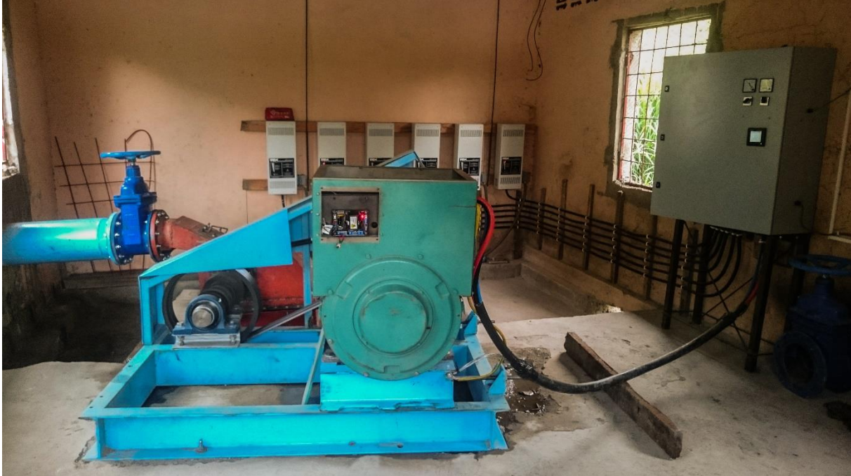
Blick in das Innere des Maschinenhauses 2 nach Fertigstellung, im Vordergrund ist der Generator zu sehen
